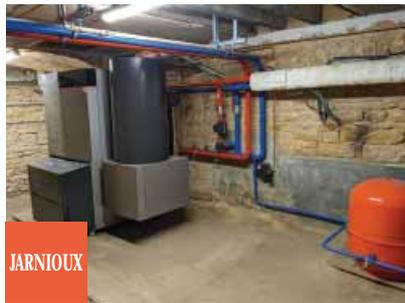
**Chauffage :** Quand cela est possible nous remplaçons les chaudières par des chaudières à bois. C'est le cas de celles de l'école et de la mairie de Jarnioux jusqu'alors chauffées au fuel.
