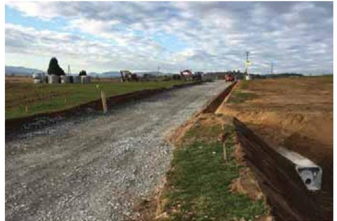
**Les travaux de la voie nouvelle se déroulent conformément au planning.** Après les travaux de terrassement nécessaires à la fondation de la voirie, les fossés ont été réalisés, ainsi que les canalisations d'eaux pluviales et les bassins de rétention. Ces derniers permettront de stocker les eaux lors de fortes précipitations afin de ne pas générer de l'érosion en aval des travaux. Un débit de fuite leur permettra de se vider sous un délai de 24h.
